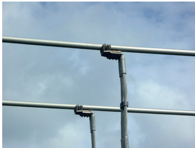
Fot. 4. Połączenie zaprasowywane przy odejściu wiązki przewodów od rury mostu.
