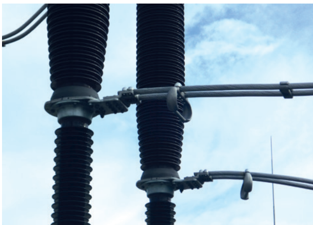
Fot. 5. Zacisk wiązkowy na płytce stykowej aparatu – stacja Słupsk Wierzbiecin.
