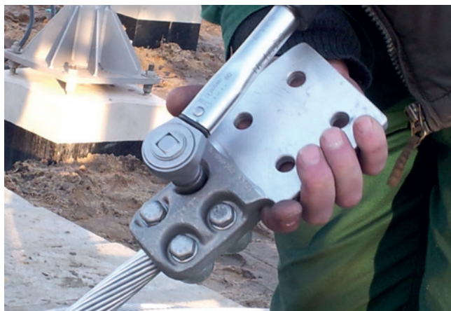
Fot. 6. Montaż zacisku skręcanego.
