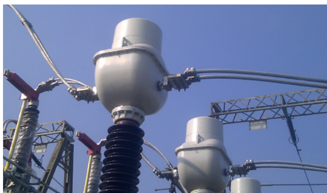
Fot. 8. Połączenie wiązkowe na zaciskach skręconych – stacja GPZ Skarbowców – Tauron Dystrybucja Wrocław
