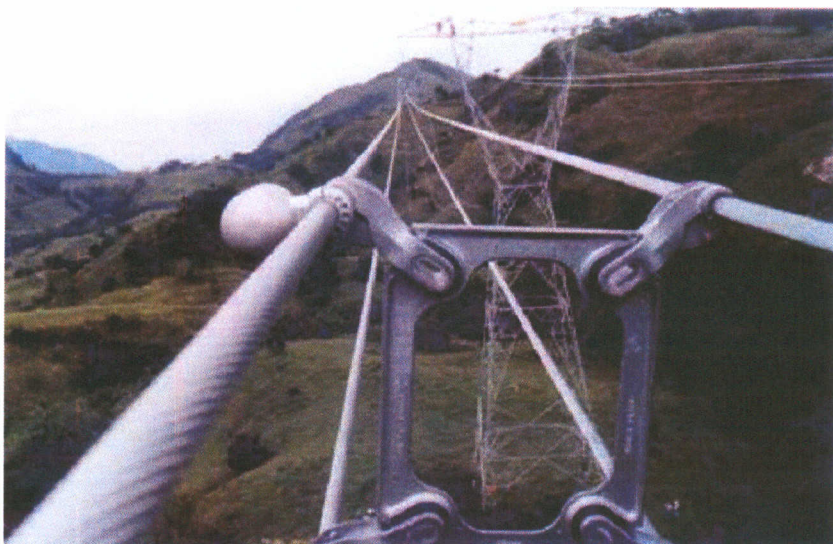
Odstępnik firmy DAMP zamontowany na linii 500 kV w Kolumbii
